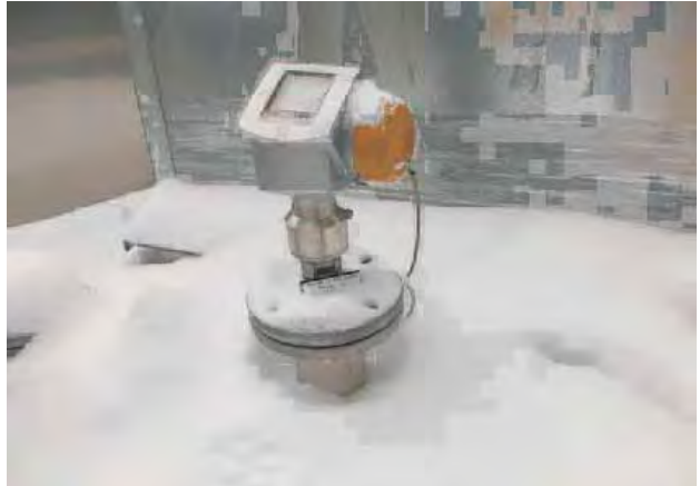
VF7. Bentonite. 11m. Steel
